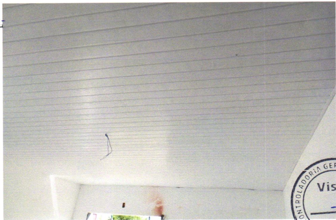
FOTO 8 – Forro de pvc, em régulas de 10 ou 20 cm, aplicado, inclusive estrutura para fixação (perfis em PVC) marca Araforros ou similar, instalado - Rev 06_10/2021
