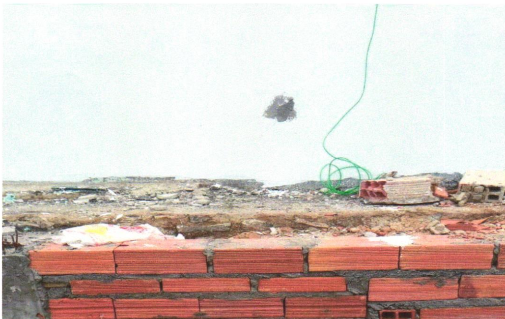
FOTO 03 - ALVENARIA DE VEDAÇÃO DE BLOCOS CERÂMICOS FURADOS NA HORIZONTAL DE 9X19X29 CM (ESPESSURA 9 CM) E ARGAMASSA DE ASSENTAMENTO COM PREPARO EM BETONEIRA. AF_12/2021
