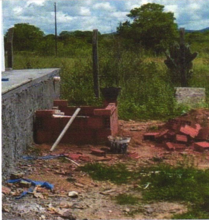
Foto 23 – FILTRO ANAERÓBIO
