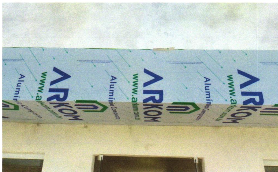
Foto 25 -Revestimento metálico em alumínio composto (Alucobond), e=0,3mm, pintura Kaynar 500 composta por seis camadas, inclusive estrutura metálica auxiliar em perfil de viga "U" de 2" - fornecimento e montagem
