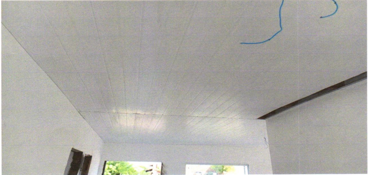
Foto 7 – Forro de pvc, em régulas de 10 ou 20 cm, aplicado, inclusive estrutura para fixação (perfis em PVC) marca Araforros ou similar, instalado - Rev 06_10/2021
