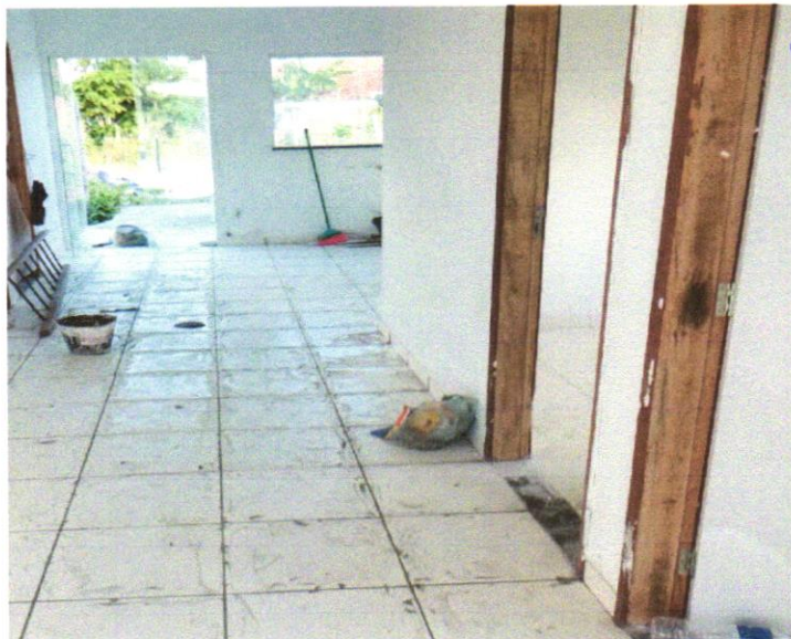
Foto 28 - REVESTIMENTO CERÂMICO PARA PISO COM PLACAS TIPO ESMALTADA EXTRA DE DIMENSÕES 45X45 CM APLICADA EM AMBIENTES DE ÁREA MAIOR QUE 10 M2. AF_06/2014
