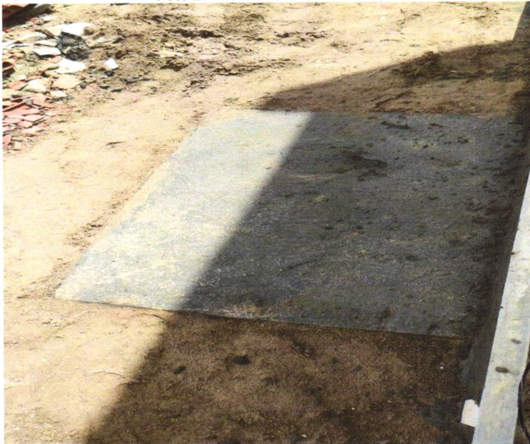
Foto 24 – Fossa séptica pré-moldada
