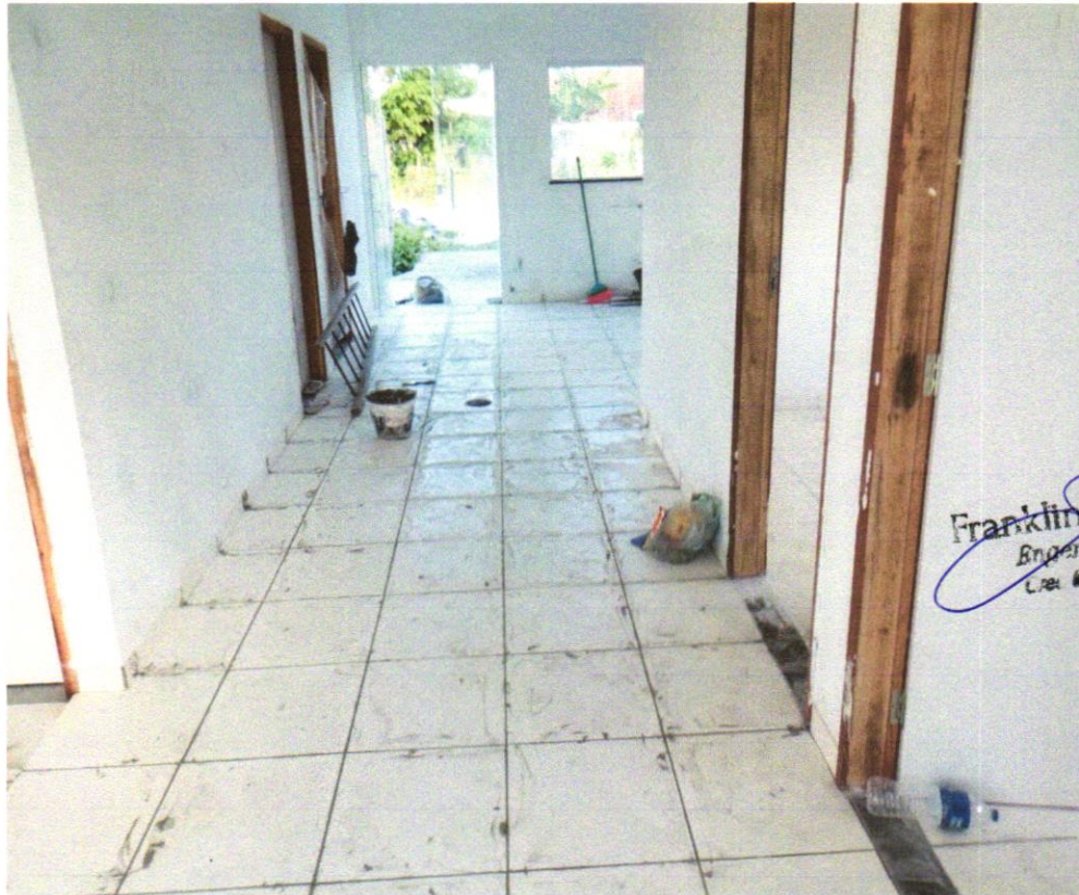
Foto 21 – RODAPÉ CERÂMICO DE 7CM DE ALTURA COM PLACAS TIPO ESMALTADA EXTRA DE DIMENSÕES 45X45CM. AF_06/2014
