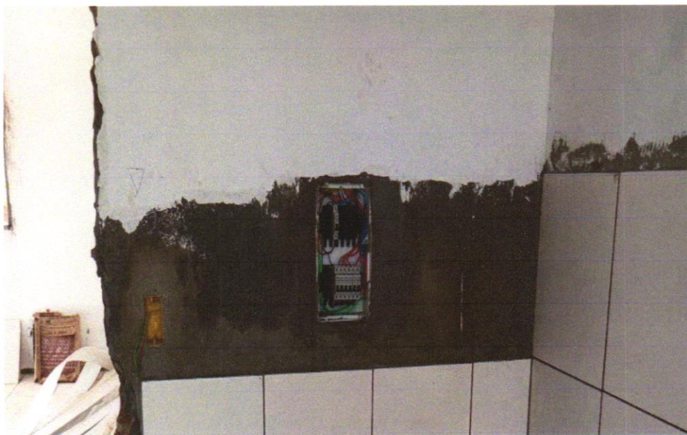
FOTO 13 - Quadro de distribuição de embutir, em resina termoplástica, para até 16 disjuntores, com barramento, padrão DIN, exclusive disjuntores
