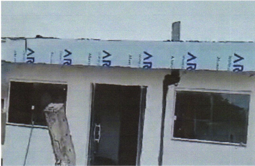
FOTO 29 - Revestimento metálico em alumínio composto (Alucobond), e=0,3mm, pintura Kaynar 500 composta por seis camadas, inclusive estrutura metálica auxiliar em perfil de viga "U" de 2" - fornecimento e montagem
