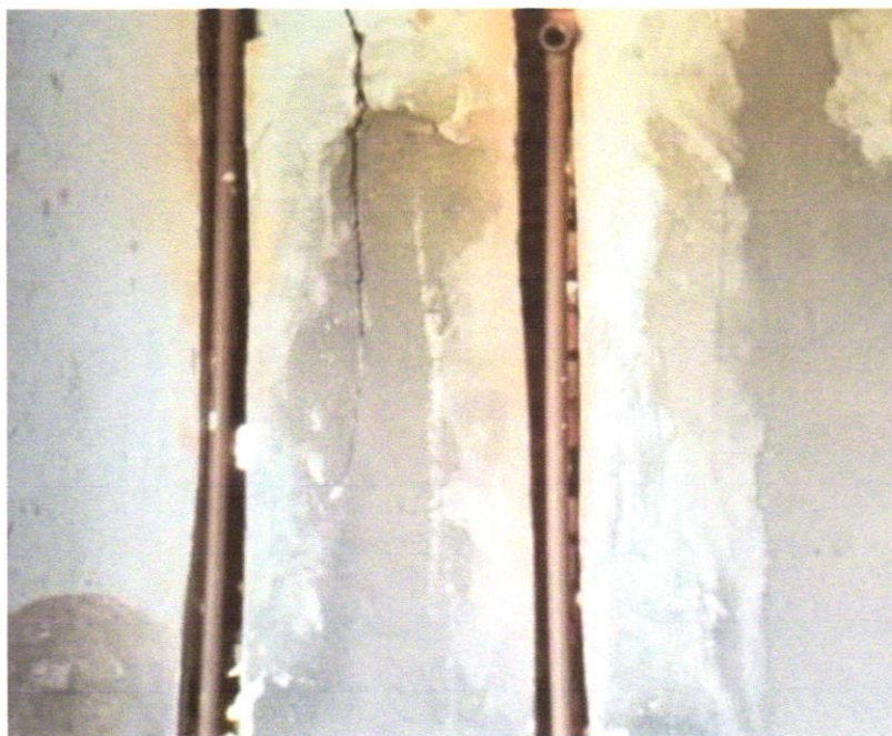
FOTO 17 - TUBO, PVC, SOLDÁVEL, DN 25MM, INSTALADO EM RAMAL OU SUB-RAMAL DE ÁGUA - FORNECIMENTO E INSTALAÇÃO. AF_06/2022
