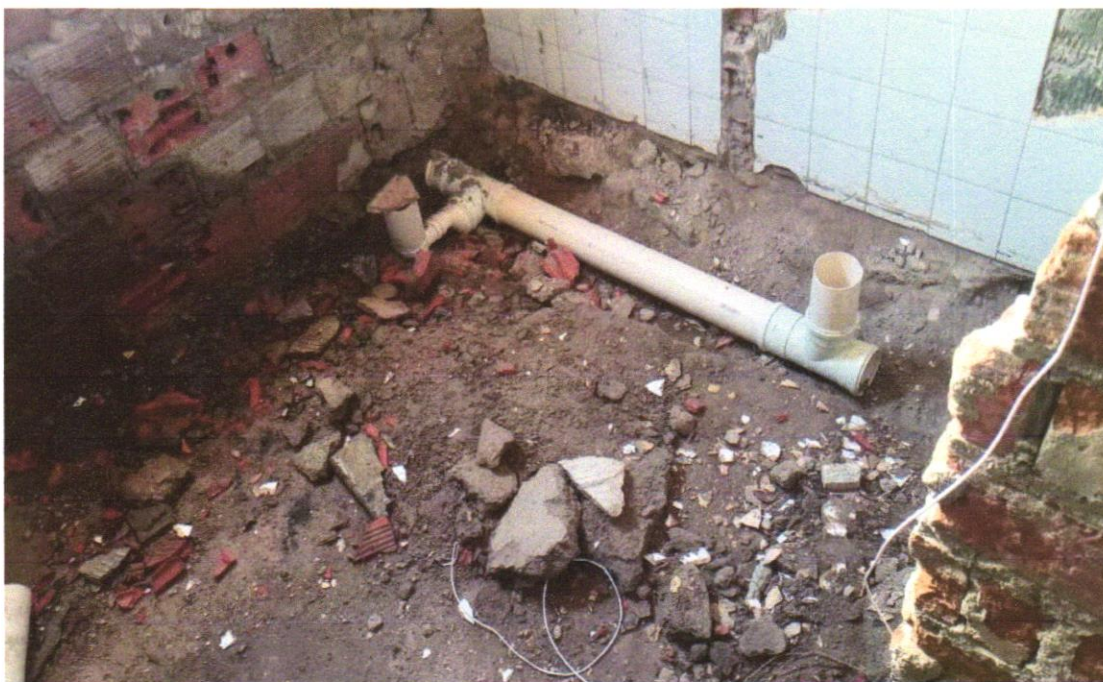
FOTO 19 – TUBO DE PVC BRANCO PARA REDE COLETORA DE ESGOTO CONDOMINIAL DE PAREDE MACIÇA, DN 100 MM, JUNTA ELÁSTICA - FORNECIMENTO E ASSENTAMENTO. AF_01/2021
